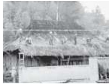
② 茅葺き屋根の解体作業
