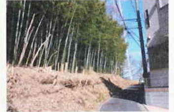
作業実施後の様子(港南区)
